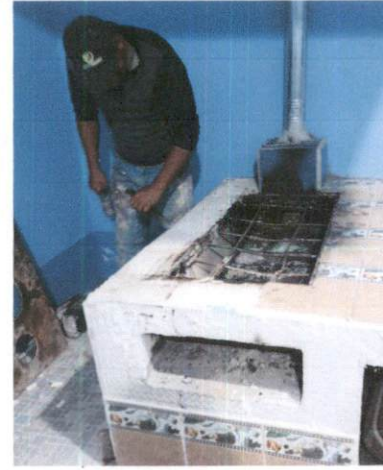
Foto 6: Se esta realizando el mejoramiento en la parte donde se encuentra la plancha de la estufa ahorradora de leña
