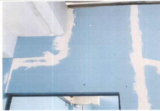
Foto 2: Se esta realizando el mejoramiento del dintel en la puerta de la cocina
